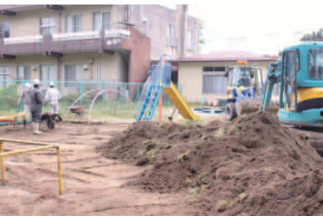
二本松市では、市民の生命と安全を守るために、放射能被ばく防止の施策が進められている。写真は幼稚園園庭の除染作業風景
